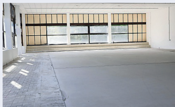
Hier ist noch eine Baustelle: Der große Klausurensaal im ehemaligen Schwimmbad soll im August fertig werden.
