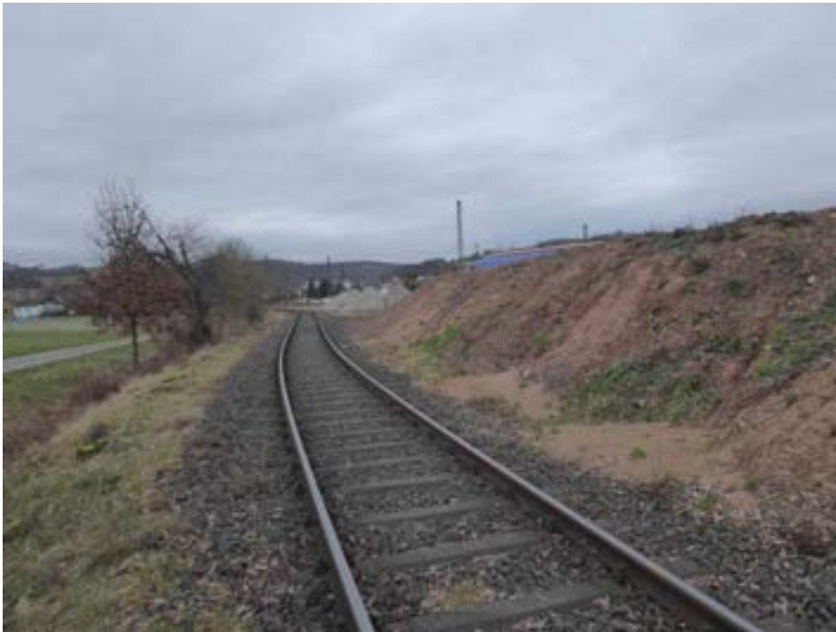
Abb. 8: Blick Richtung Nordwest, rechts die zur Befestigung vorgesehene Freifläche, links Böschung mit Graben
