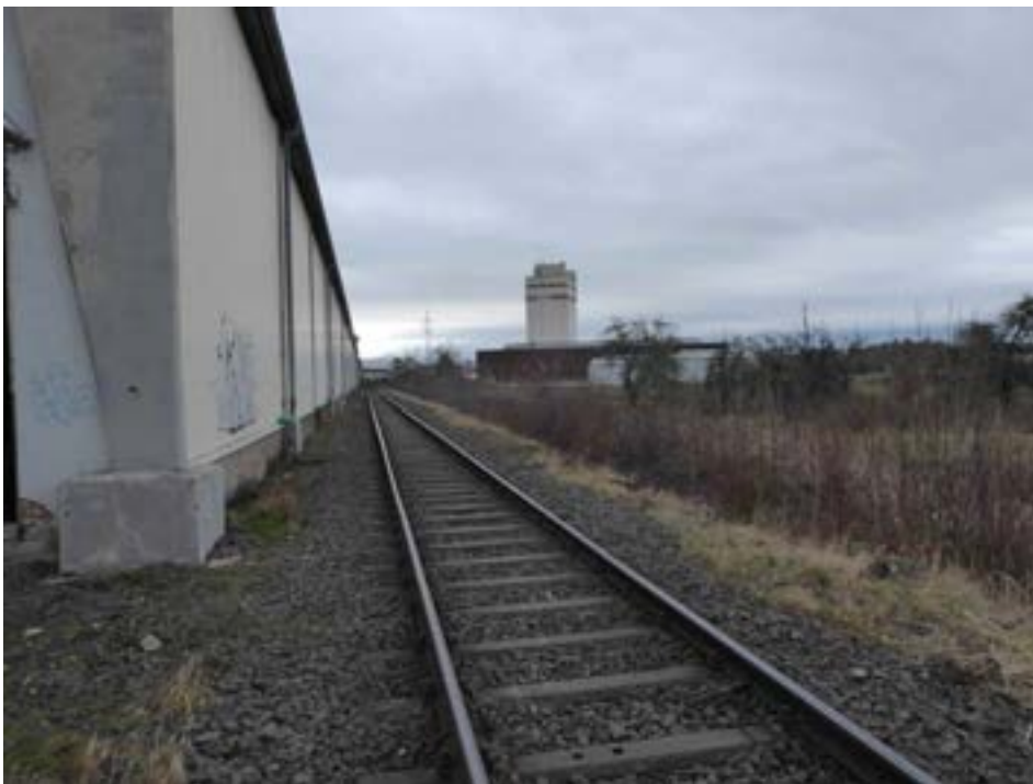
Abb. 7: Blick von Nordwest nach Südost entlang der Umladehalle mit angrenzendem Gleis
