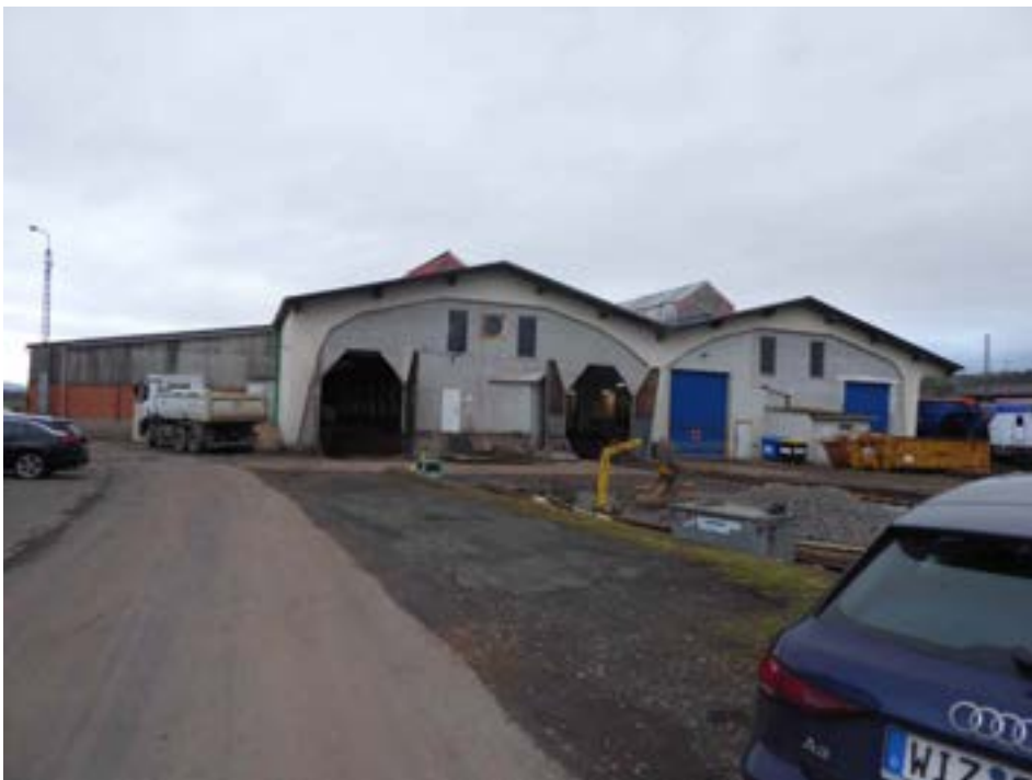
Abb. 3: Eingangsbereich der Umladehalle auf Bebraer Gemeindegebiet
