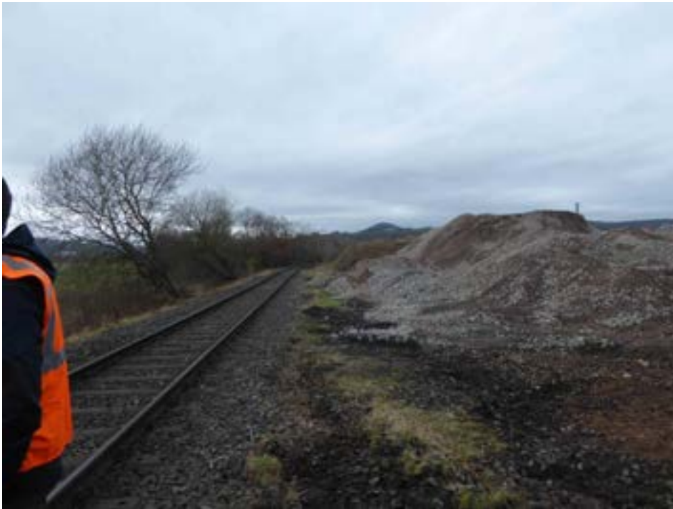
Abb. 6: Freifläche hinter der Umladehalle mit seitlich (südwestlich) angrenzendem Bahngleis
