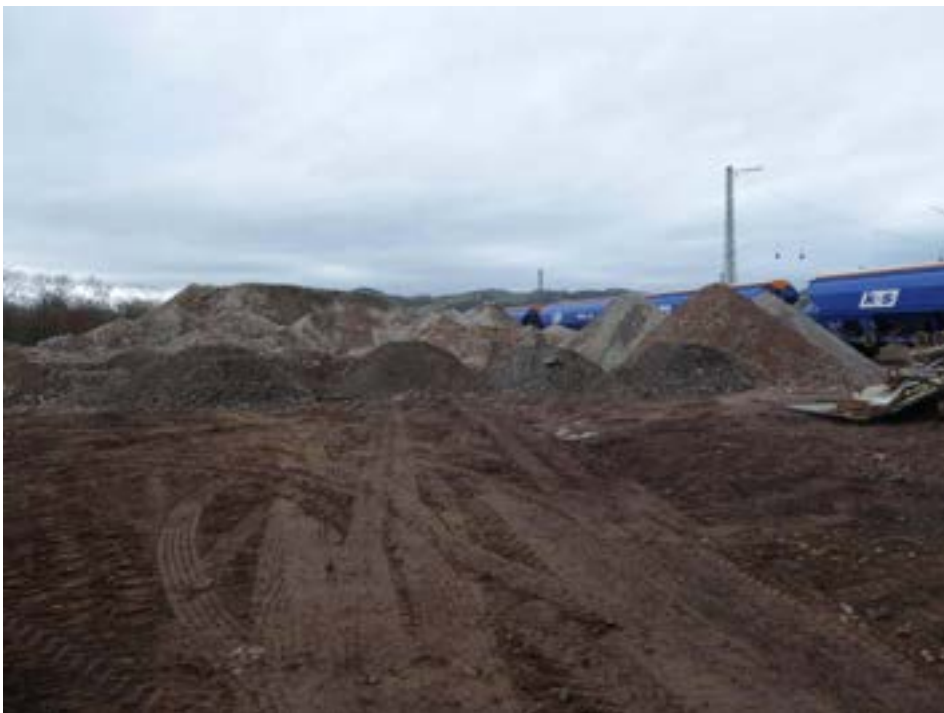
Abb. 5: Freifläche hinter der Umladehalle
