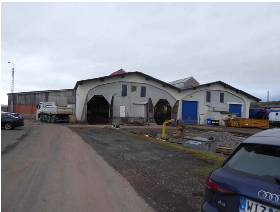
Abb. 3: Eingangsbereich der Umladehalle auf Bebraer Gemeindegebiet
